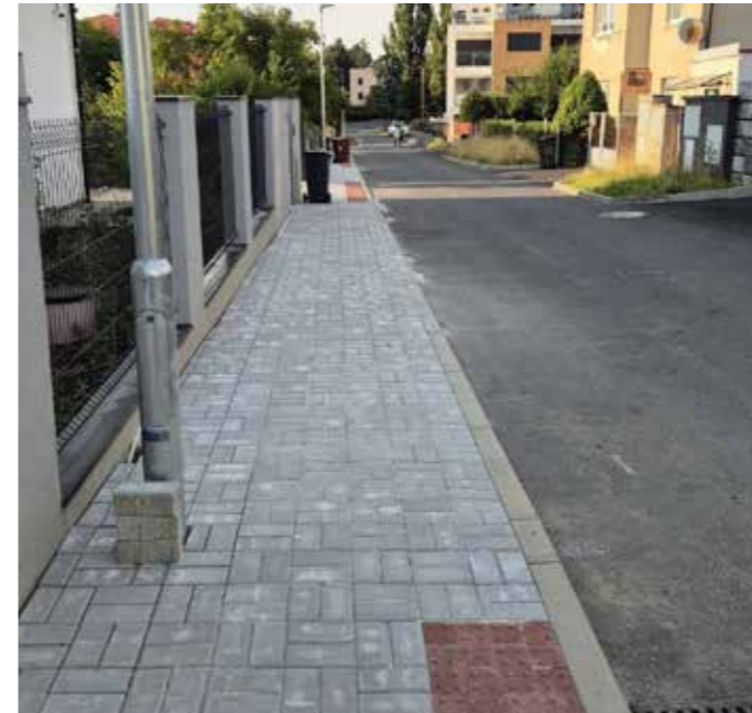
Chodník Verdunská ulice
