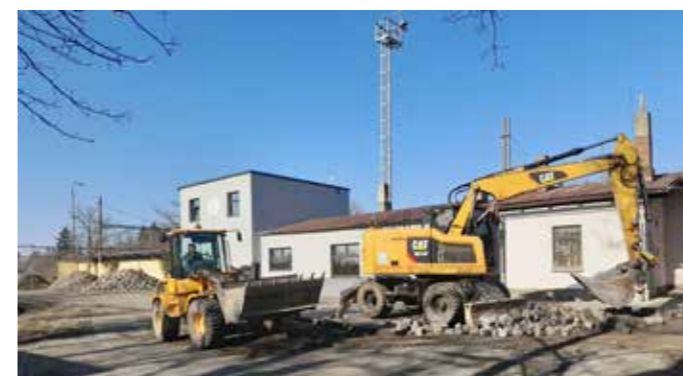
Práce na rekonstrukci parkoviště P+R u nádraží pokračují podle plánu
