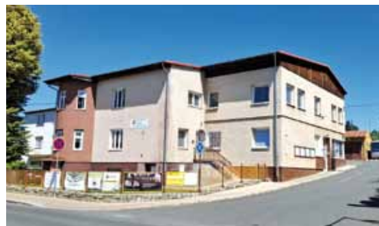
V areálu sídlí i finanční úřad, který zde bude fungovat i nadále.
