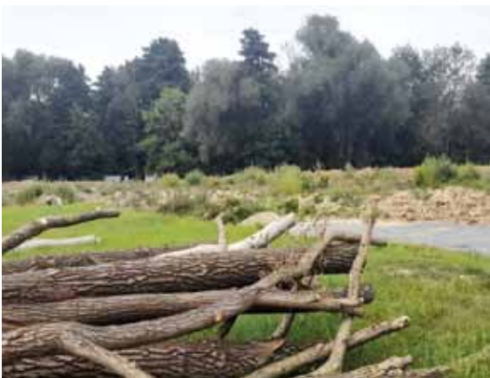
Areál je po náročných demoliciích hal připraven pro další úpravy.
