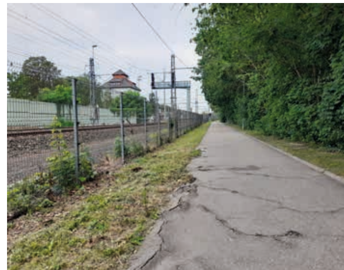
Zahájíme opravu chodníku u železniční trati
