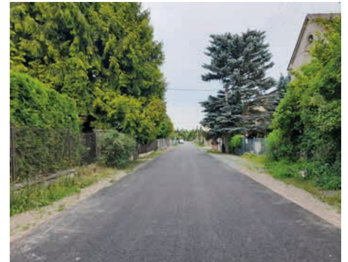
Oprava ulice Čajkovského byla dokončena.
