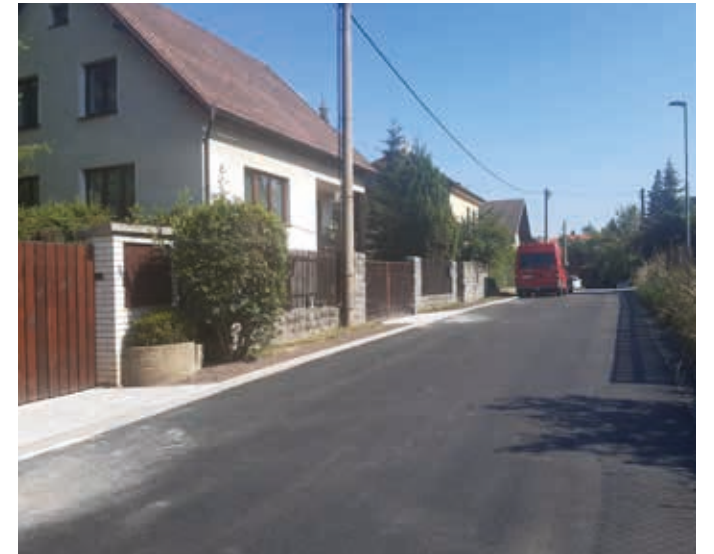
Komunikace Pivoňková dostala nový asfaltový povrch.
