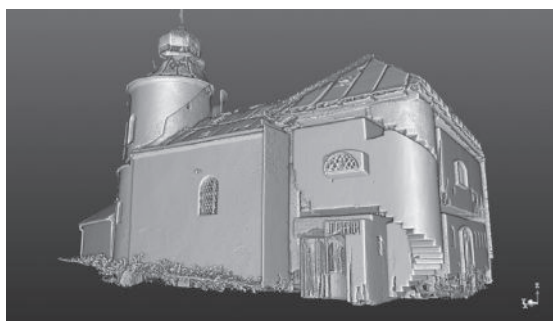
Neupravený výstup z laserového skeneru umožňuje pohled na kostel ze zcela neobvyklých úhlů. Díky tomu je možné odhalit i případné skryté prostory.
