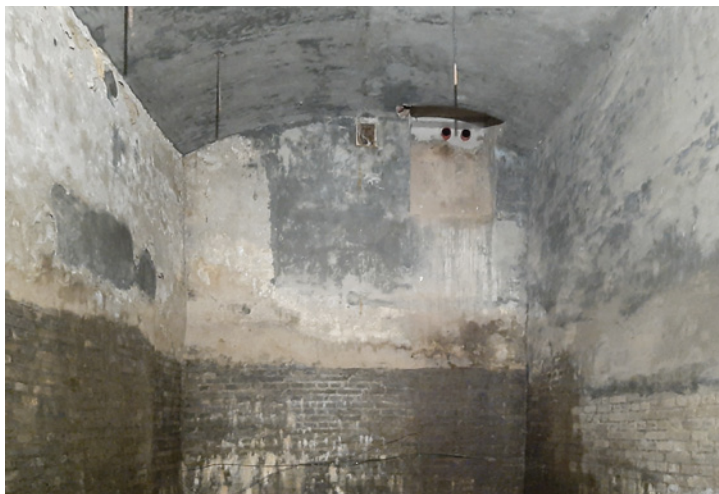
Hluboký sklep (= lednice) s podstropním skluzem ledu z náměstí
