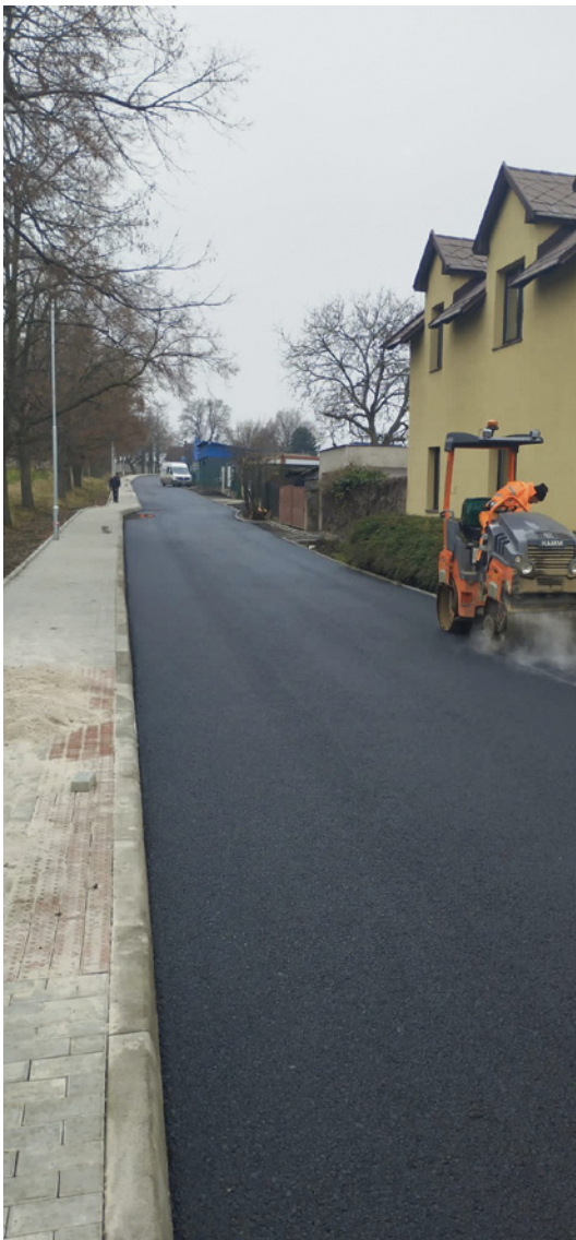
Vozovka dostala nový asfaltový povrch.
