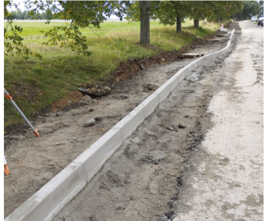
Zahájení prací v ulici Ke Solné stezce.
