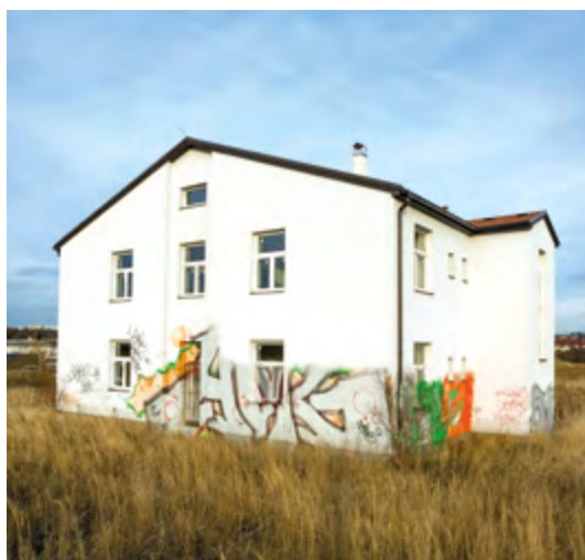
Nedostavěné budoucí sídlo KSÚS v ulici Kolovratská
