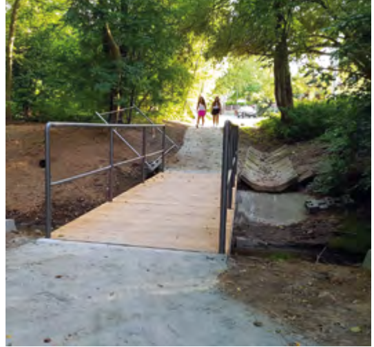
Nová dřevěná lávka přes Řičanský potok
