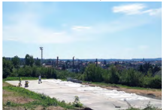
Betonová plocha pro skatepark je již hotová
