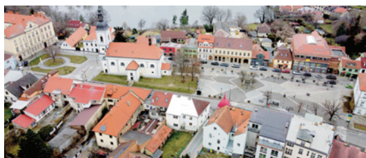
Pošta dokončila rekonstrukci objektu na administrativní budovu koncem roku 1994
