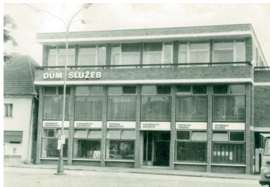
Fotografie roku 1979, kdy budova fungovala jako Dům služeb
