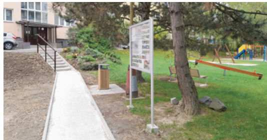
Propojovací chodník k věžáku v Plynárně
