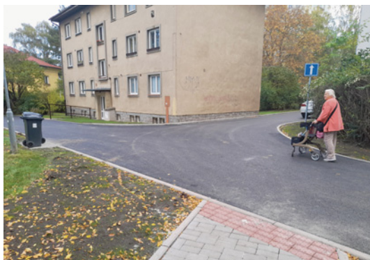
Opravená ulice U Kina
