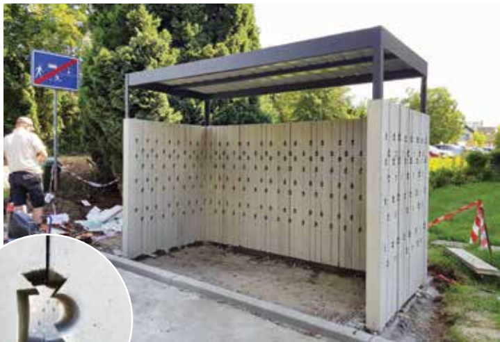
Ulice Haškova, nové stání separovaného dopadnu. Stanoviště v ulici Haškova bude provedeno z betonových panelů, do kterých je vložena forma s logem města. Výhodou tohoto materiálu je dlouhá životnost a bezúdržbovost.
