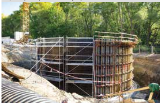
Příprava výztuže před betonáží a již vybetonovaná část usazovací nádrže.
