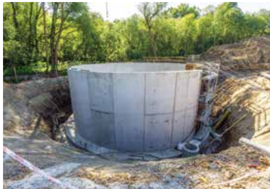
Stávající aktivační nádrž. Stavba probíhá při zachování plného provozu ČOV.
