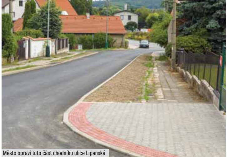
Město opraví tuto část chodníku ulice Lipanská
