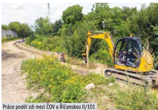
Práce podél zdi mezi ČOV a Říčanskou II/101
