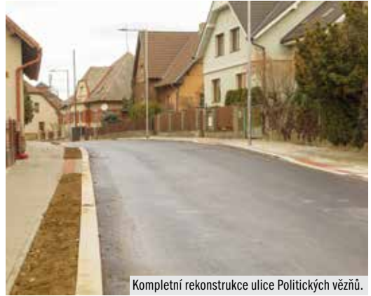
Kompletní rekonstrukce ulice Politických vězňů.
