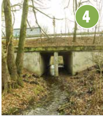
Z Vysoké povede trasa k propustku pod 101 kde bude přeloženo současné koryto potoka do nového průtokového otvoru a stávající koryto bude sloužit pro pěší, cyklisty a bruslaře.
