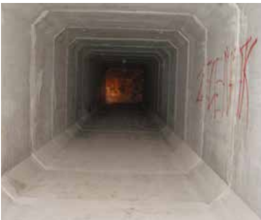
Zazděný podchod pod tratí
