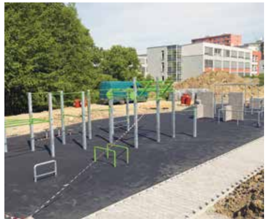
Workout fitness je instalován a čeká na nástřik dopadové plochy
