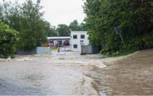
Při povodňové vlně se přelila voda přes hráz do areálu SUS pod Mlýnským rybníkem
