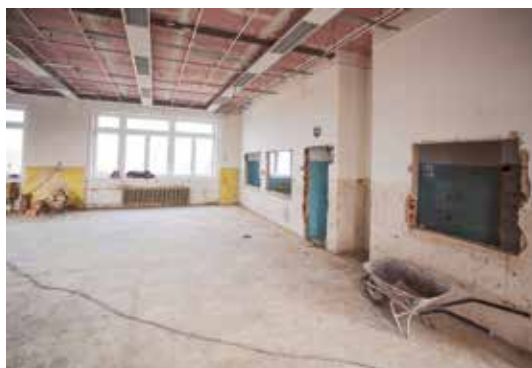
Během jara se stavební práce přesouvají do prvního patra, kde vzniknou tři kmenové třídy pro 90 dětí.
