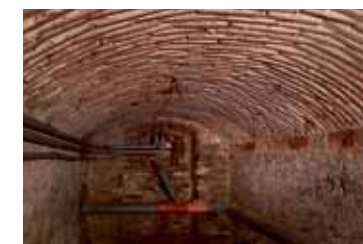
Klenbový cihlový strop ve sklepech z šedesátých let 19. století
