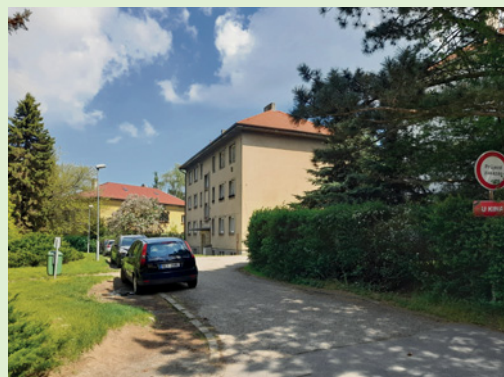
Opravíme i ulici U Kina.
