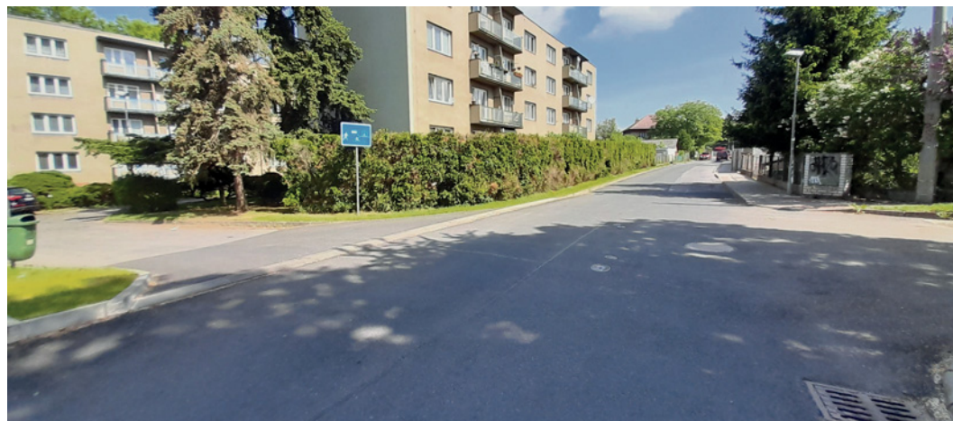
Po loňské úpravě křižovatky projde ještě letos opravou celý povrch Haškovy ulice včetně rozšíření parkoviště.
