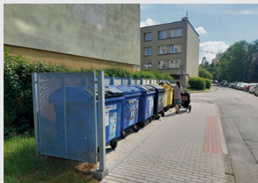
Stanoviště na separovaný odpad byla opatřena hrazením z tahokovu.
