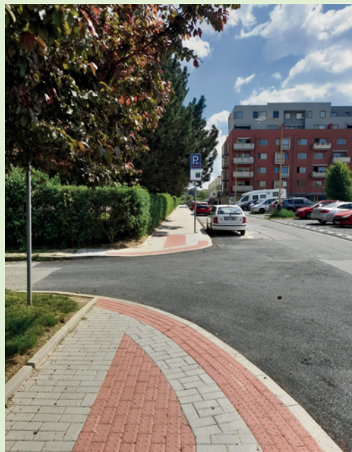
Opravený chodník na Komenského náměstí
