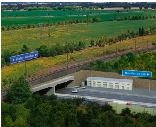
Přes jižní portál tunelu Na Vysoké vede železniční trať Praha-Benešov.
