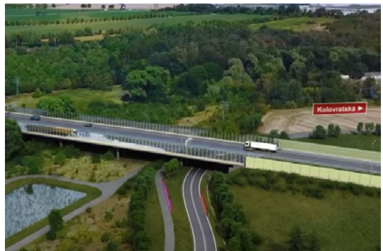
Most přes Říčanský potok – pod ním povede přeložka ulice k Říčanům, respektive Kolovratská a přeložka cyklostezky „Do Prahy na kole“. Na obou stranách komunikace budou protihlukové stěny.
