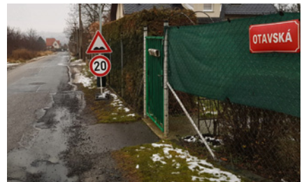
Velká část z rozpočtu poputuje na investice do dopravní infrastruktury. Alokováno je zhruba 60 milionů korun z investic plus dalších 21 milionů z položky na opravy silnic a chodníků. Opravy se dočká například ulice Otavská.
