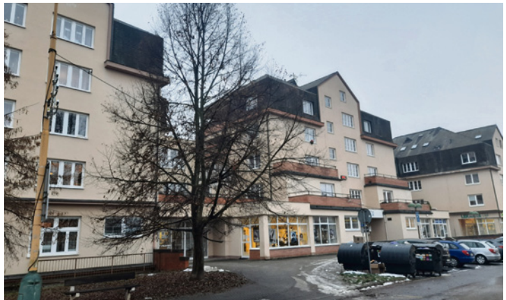
V rozpočtu je také alokováno 13 milionů korun na opravu střechy DPS.
