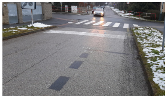
V ulici Táborská byl zpomalovací polštář nahrazen novým vodorovným značením. Také bylo odstraněno parkovací místo, které bránilo plynulému provozu.
