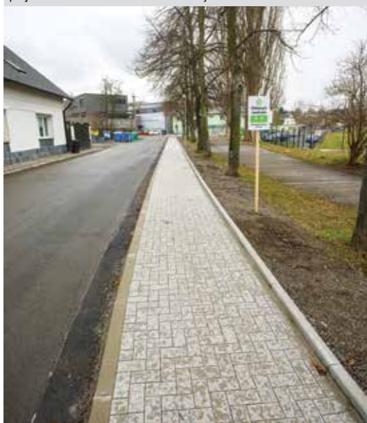
Nově dokončený chodník v ulici Olšany slouží nejen k bezpečnějšímu příchodu do očkovačického centra. Bezfasetová dlažba umožní též hladký průjezd bruslařů či dětí na koloběžce k cyklostezce
