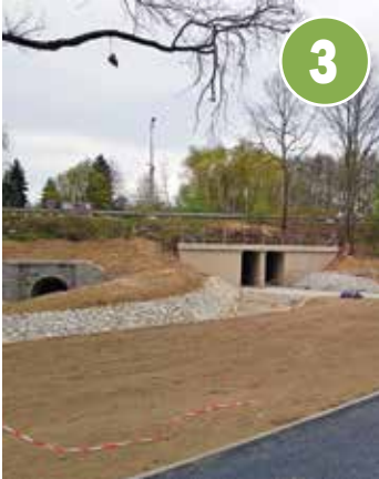
Pod Říčanskou ulicí je potok sveden mimo propustek.
