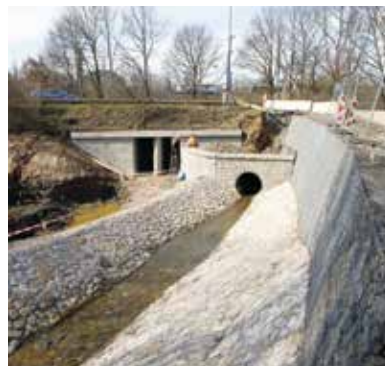
Pohled na propustek od příjezdu ke sběrnému dvoru. Vpravo nové koryto Říčanského potoka.
