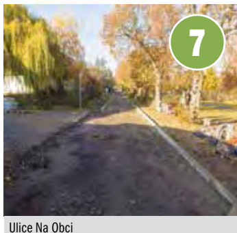
Ulice Na Obci
