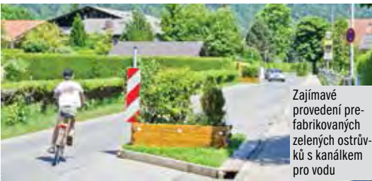
Na české poměry těžko uvěřitelné řešení – stromy uprostřed ulice. V Německu běžná záležitost
