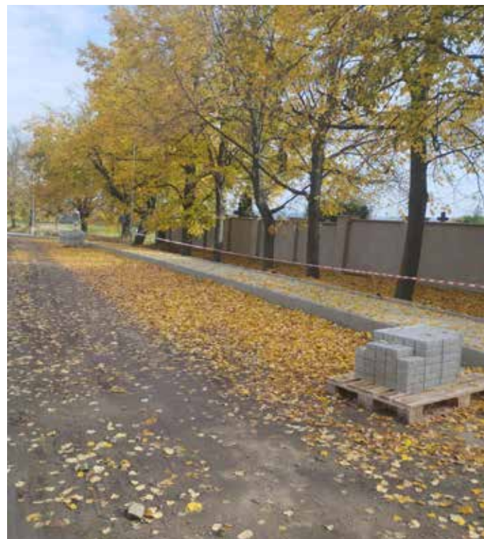
Práce na novém chodníku a opravě komunikace Ke Solné stezce, jenž vede ke hřbitovu, úspěšně pokračují.
