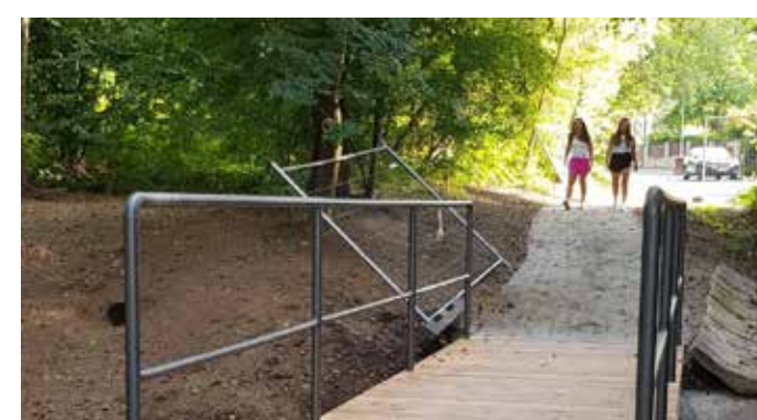
Nová lávka za zimním stadionem.
