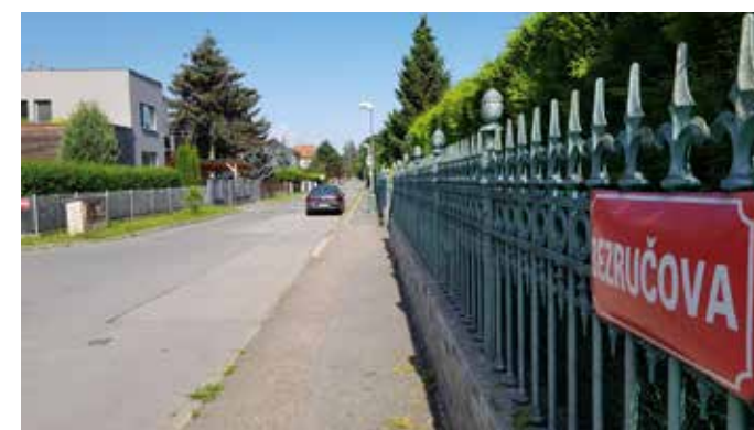
Zahájili jsme opravu chodníku v Bezručově ulici
