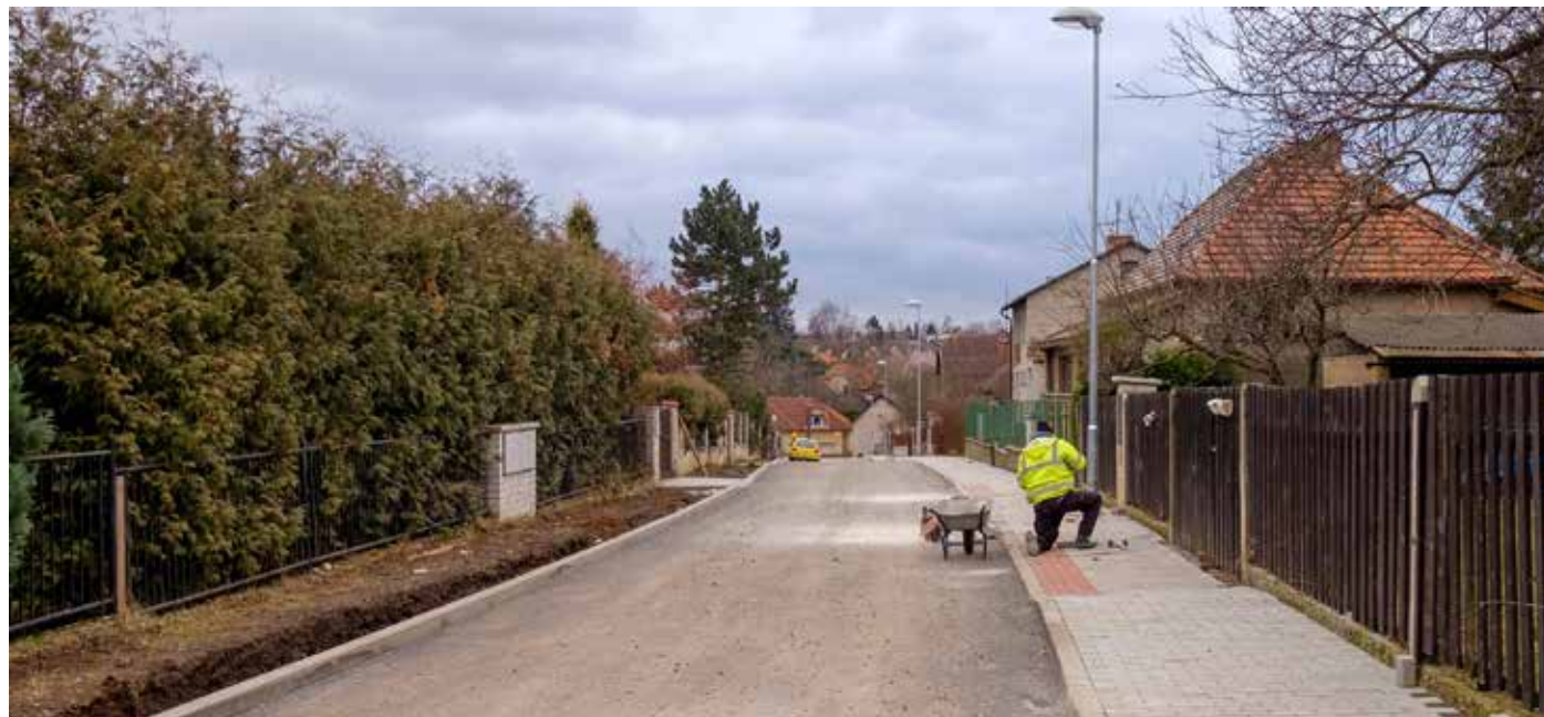
Náročná kompletní rekonstrukce ulice Nedbalova je po půl roce dokončena. Město za tuto náročnou investiční akci zaplatí zhruba 9 milionů korun. Opraveny nebo dobudovány byly inženýrské sítě – vodovod, dešťová a splašková kanalizace. Hotov je asfaltový povrch, nový chodník a veřejné osvětlení.
