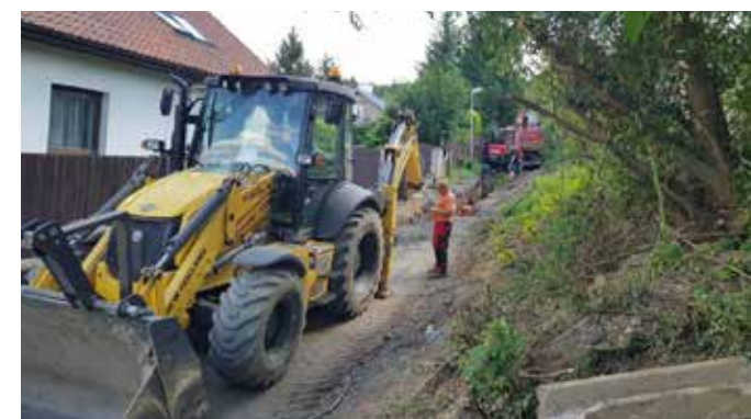
Oprava vodovodu a plynových přípojek v ulicích Sokolovská, V Doubí a Zahradní
