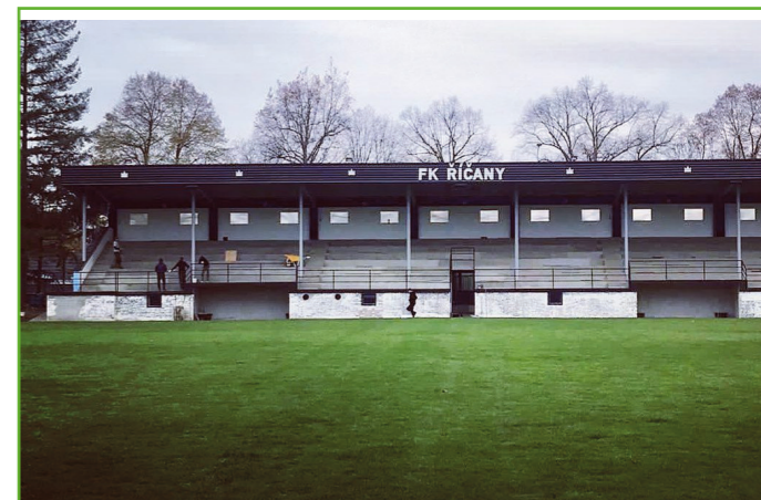
V lednu byly dokončeny stavební práce na rekonstrukci fotbalové tribuny FK Říčany.
