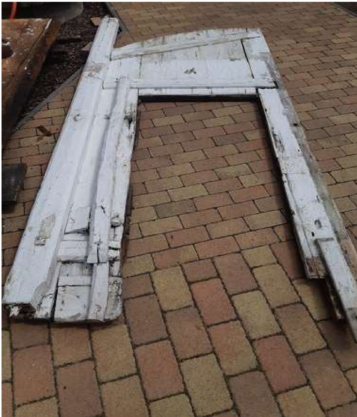
celkový pohled na levé křídlo vrat před restaurováním (pohled ze dvora)
