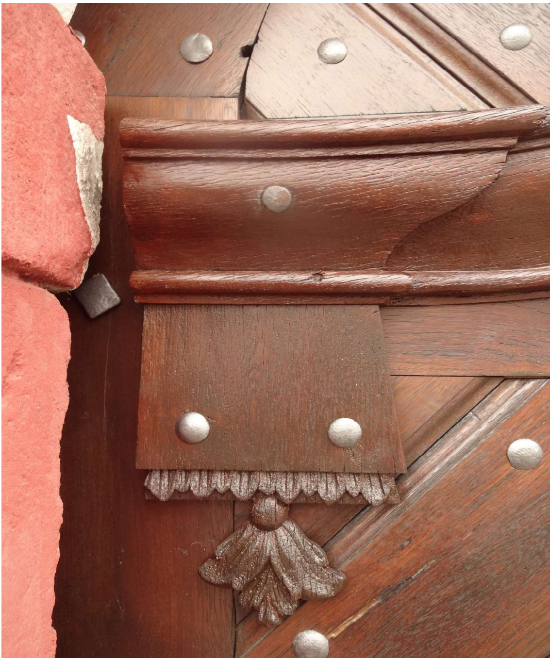
detail původních zrestaurovaných prvků včetně originálních hřebů
