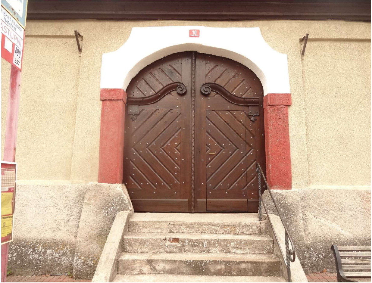
pohled na zrestaurovaná vrata - pohled z ulice
