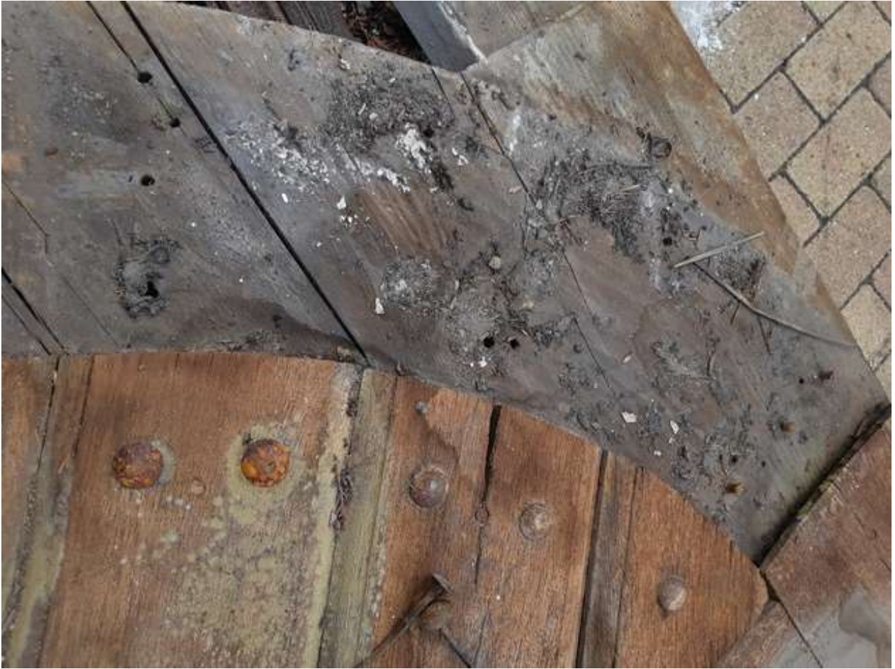
demontáž původních dubových prken s hřeby - stav v průběhu prací
