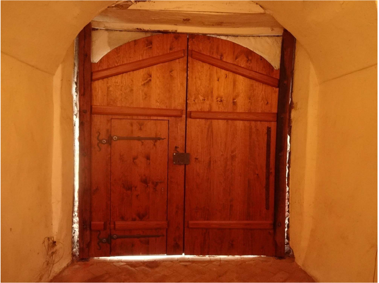
vrata po restaurování a osazení pohled ze dvora
