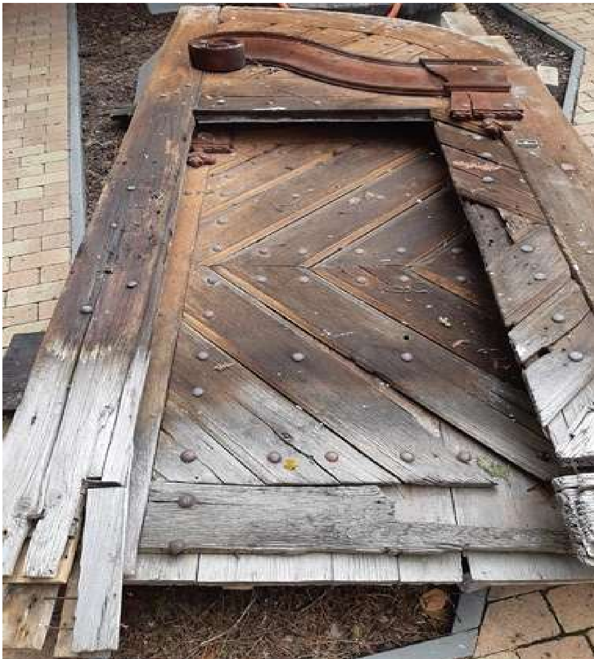
celkový pohled na levé křídlo vrat před restaurováním
