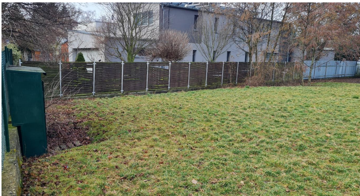
Obrázek 3: Pohled na stávající oplocení ze strany parku – nalevo dřevěná část
