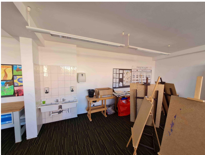
Obrázek 4: Pohled na příčku do které budou vybourány dva vstupní otvory pro dveře
