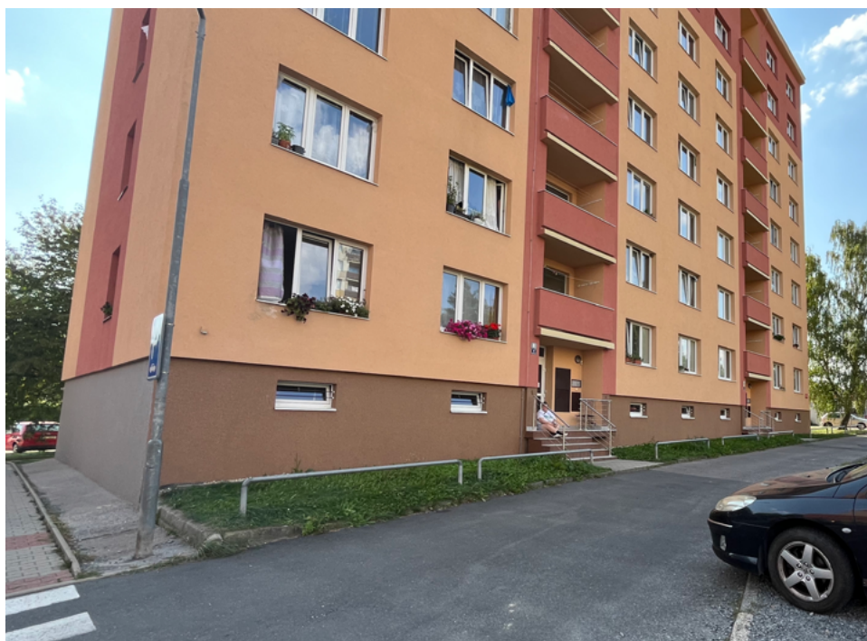
Technicky udržovaná plocha, optimální jsou předzahrádky u vstupů do bytových domů.
