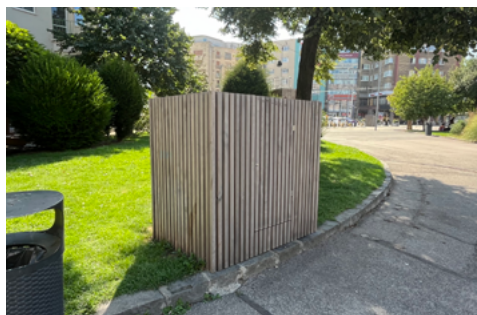
Krytí odpadů a rozvaděčů
