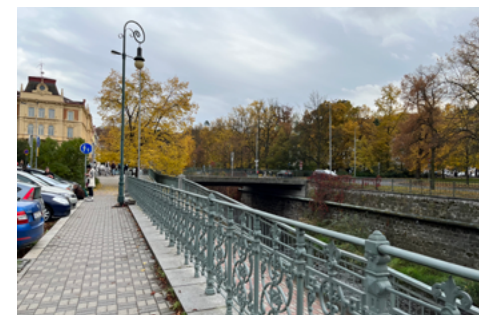
Zábradlí a lampa
