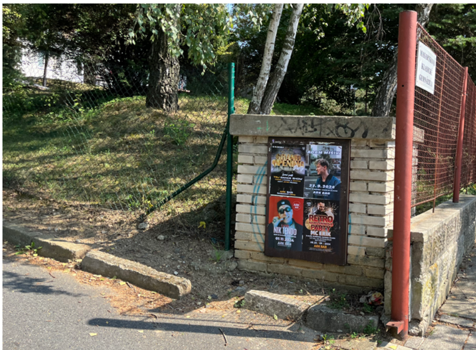
Ukázka tagovaného rozvaděče s ilegálním výlepem. Samotný výlep je možné eliminovat ozrněným nátěrem, na kterém žádné samolepky ani plakáty nedrží.
