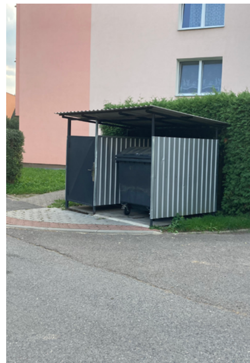
Konstrukce z nejlevnějších materiálů stále vytváří dojem úhlednosti (Lanškroun).
