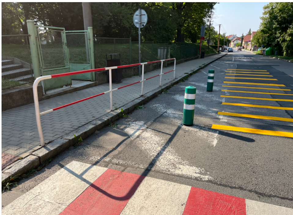
Provizorně řešené sloupky a vodorovné značení
