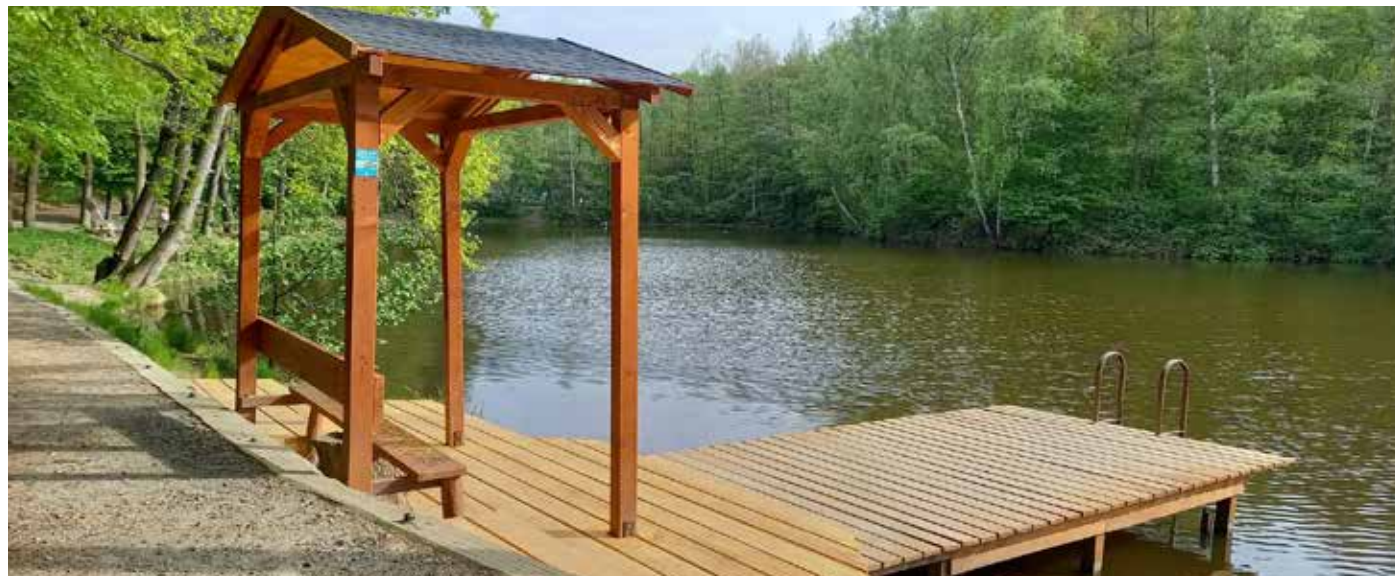
U mola na Jurečku byl přístaven přístřešek a vstup na molo byl zpevněn dřevěnými schody.
