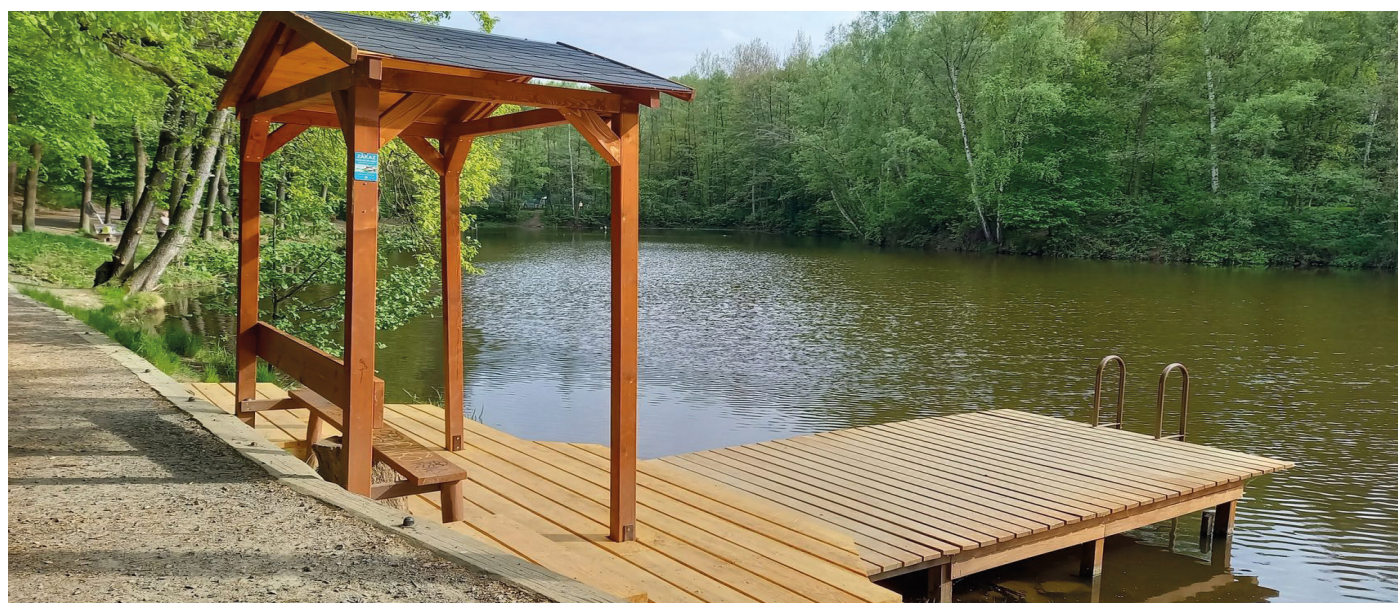
U mola na Jurečku byl přistaven přístřešek a vstup na molo byl zpevněn dřevěnými schody.
