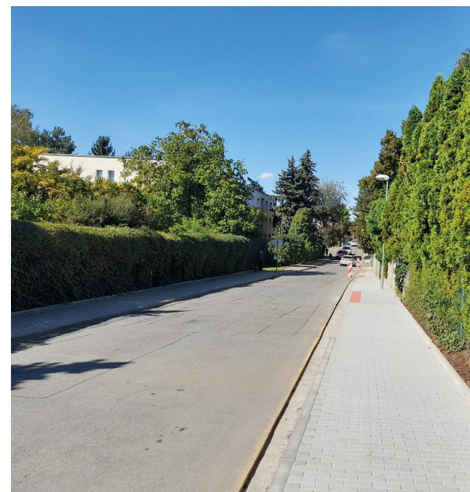
Oprava chodníku v ulici Domažlická byla dokončena.
