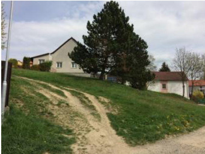
Pohled z ulice Nad Studánkou
