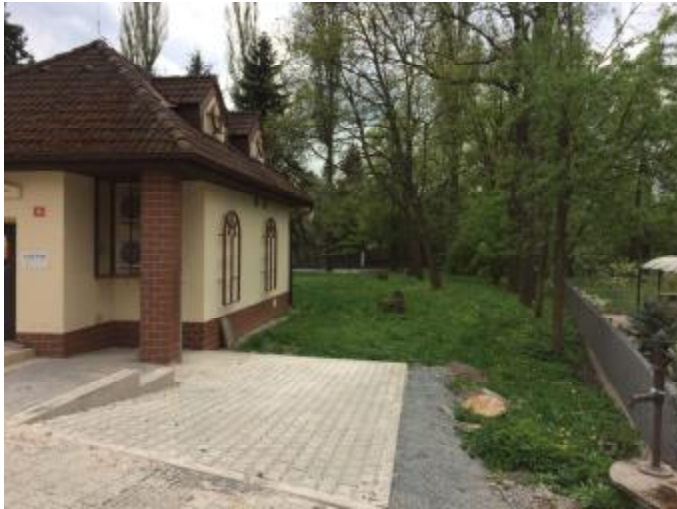
Pohled z ulice Nad Studánkou
