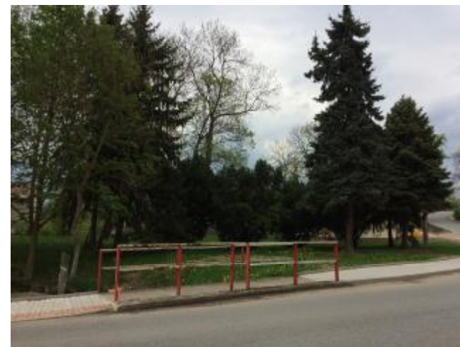
Pohled na mostek v ulici Na Lada
