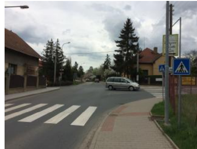
Pohled z ulice Hlavní
