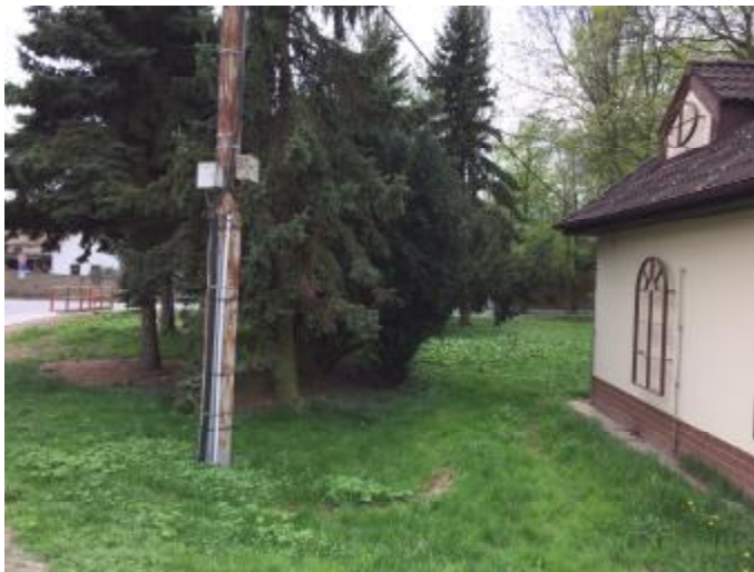
Pohled z ulice Nad Studánkou
