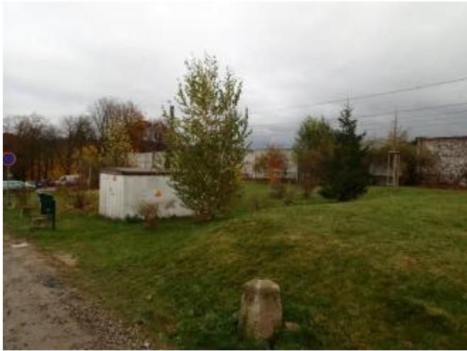
Trafostanice v ulici Dlouhá
