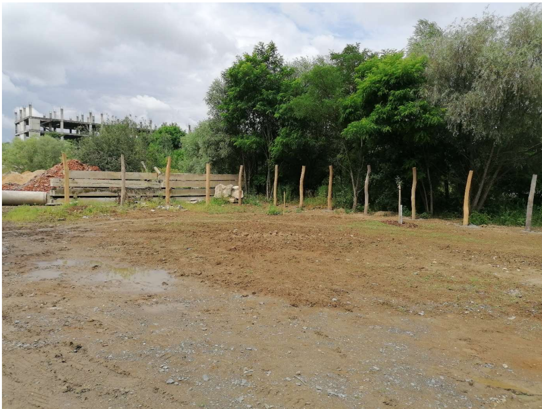
17.7.2020 Realizace palisádového plotu
