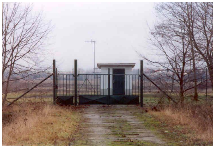
Obr. 15 Objekt na štolovém přivaděči Š4 Jesenice
