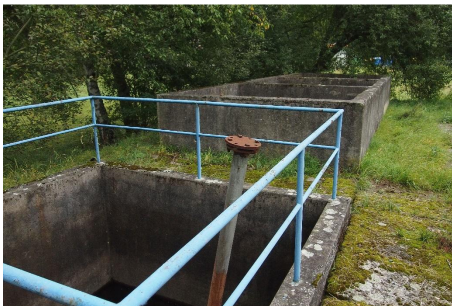
ÚV Radošovice – kalové hospodářství
