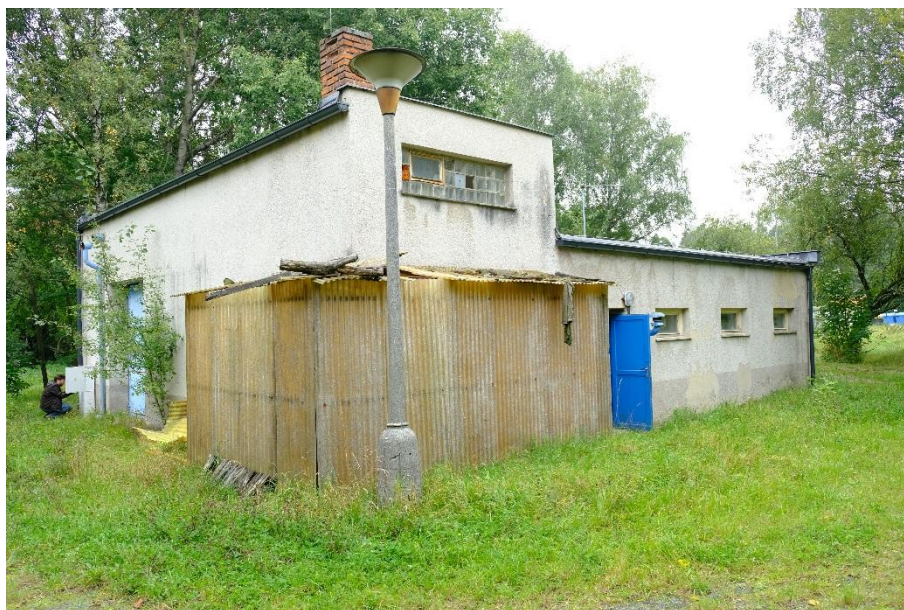
ÚV Radošovice – budova úpravy vody
